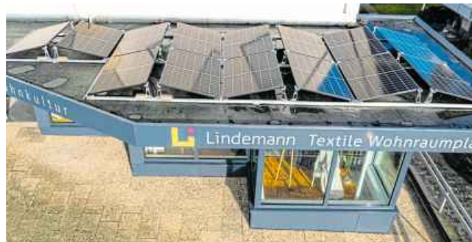
Photovoltaikflächen auf dem Vordach: So produziert Lindemann Wohnkultur Strom, den der Betrieb für Raumausstattung tagsüber verbraucht, beispielsweise für Bügelanlagen und Waschmaschinen.
